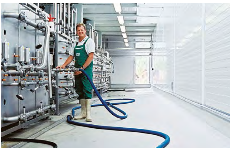
Braukommune Freistadt: Bei der neuen Anlage wurde auch großer Wert auf den Arbeitnehmerschutz gelegt.
