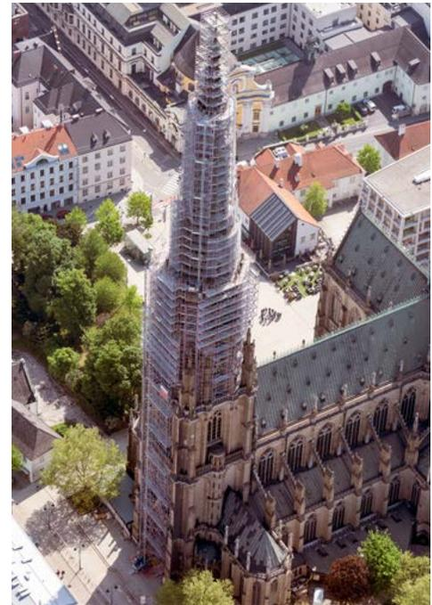
Abbildung 1: Ein Stahlrahmengerüst am „Maria-Empfängnis-Dom“ in Linz, Österreich. Das Gerüst wurde aufgebaut, um Arbeiten an der Kathedrale (leichter) durchführen zu können. (Layher Österreich Gerüstsysteme GmbH)
